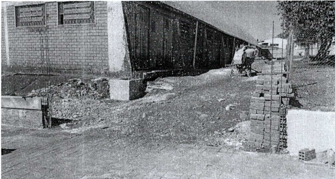
Neste espaço deverá ser feita a instalação do item 02 (portão de correr).
