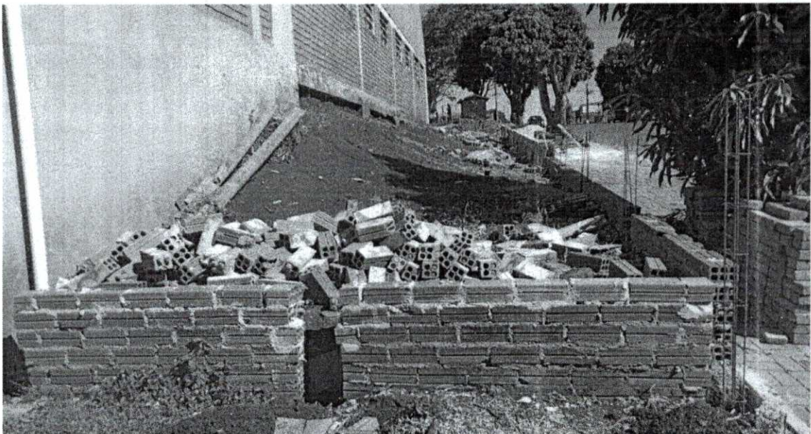
Neste espaço a instalação do item 3.
