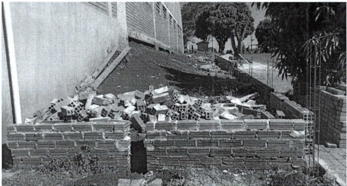
Neste espaço a instalação do item 3.
